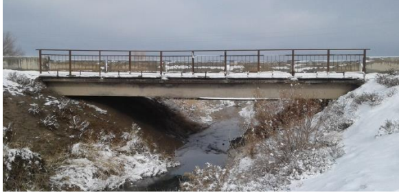
Рис.1. Железобетонный мост с автодорожной балкой
